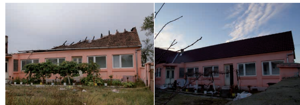
Das Haus Primavera nach dem Brand und seinem Wiederaufbau
